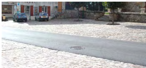
Exemple de traitement de la voirie (Cormeilles-en-Vexin) : la route est en enrobé et tout autour l'espace public est traité de niveau avec des pavés en grès.
