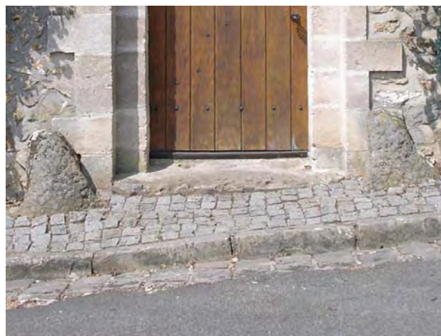
Rue de l'Eglise : bordures, revêtement des trottoirs et fil d'eau traité en grès.
