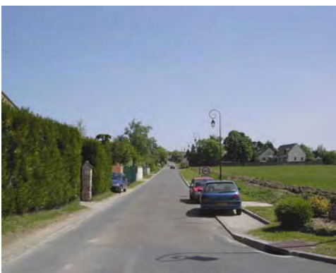
Etat existant de la rue de Normandie
