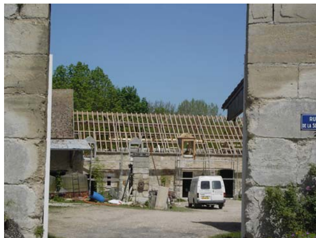
L'ancienne ferme Seigneuriale est en travaux : un permis de construire a été délivré pour la transformation de l'étable en un logement. C'est aussi le cas de la ferme située sur le chemin rural de Rhus à Berval.
